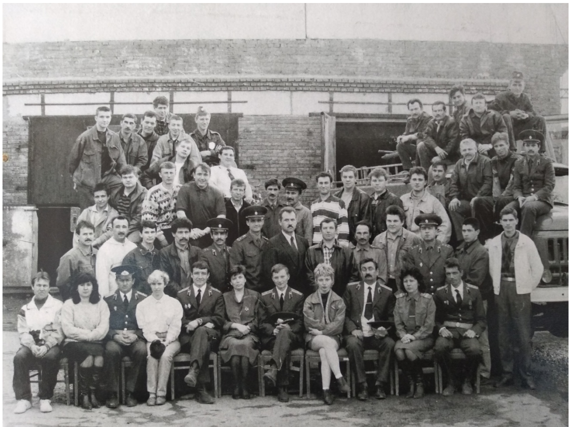
Личный состав ВПЧ-65 на фоне строящегося пожарного депо, 1984-1985 год
